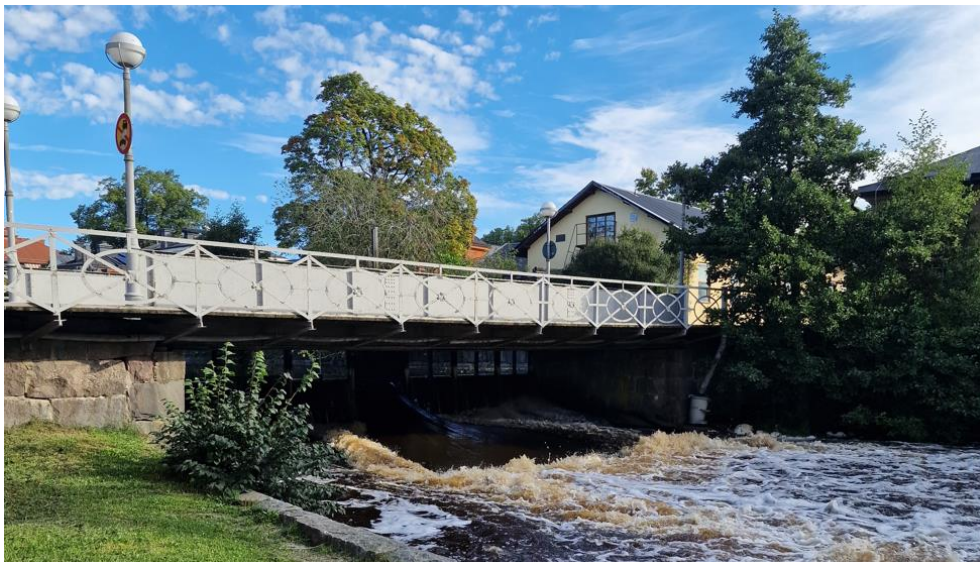
Figur 1. Nedströmsvy av Dambron i Köpingsån belägen i centrala Köping.
